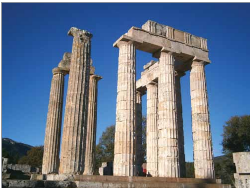
Ναός Νεμέας. Πιλοτική Εφαρμογή Μεθοδολογίας Προσεισμικού Ελέγχου Μνημείων σε κίονα του Ναού. (Πηγή: Παραδοτέο Ο. Μ. της δράσης για τον Προσεισμικό Έλεγχο των Μνημείων του Ε.Κ.Π.Π.Σ.).
