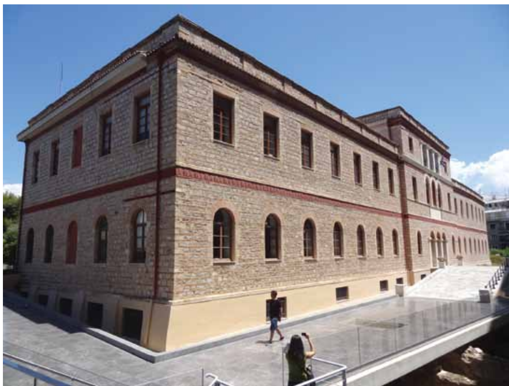
Πιλοτική εφαρμογή της μεθόδου Δευτεροβάθμιου Προσεισμικού Ελέγχου για κτίρια από τοιχοποιία στο Κτίριο Weiler (Μακρυγιάννη 2-4, Ακρόπολη)
